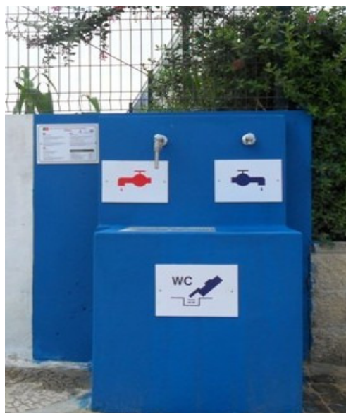
Área de Serviço de A-dos-Cunhados – Torres Vedras
